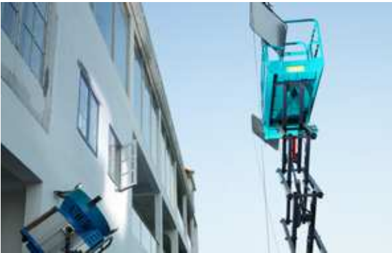
无需吊挂灯具，高效安全控光。
